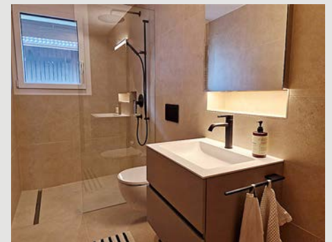
Badezimmersanierung in Birrhard
