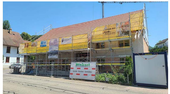
Neubau MFH in Elfingen
