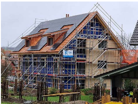
Neubau 2-FH in Oberhof
