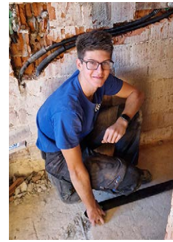
Manuel im Rohbau
